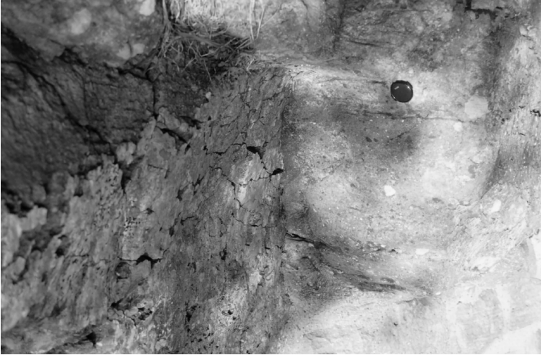
Photo 11 : Soubassement du château - miroir de faille minéralisé
