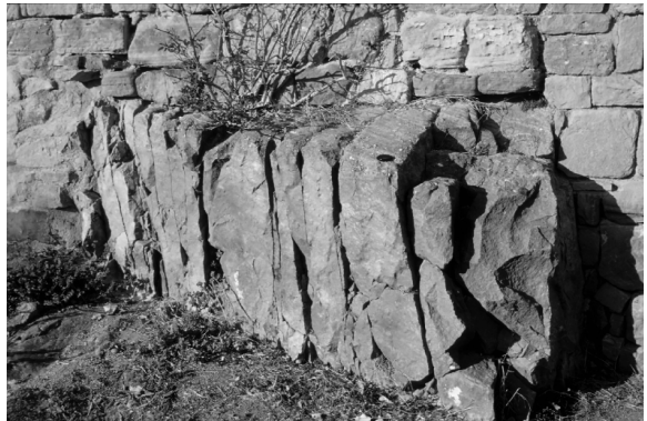
Photo 9 : Soubassement du château. Remarquez les différentes failles
